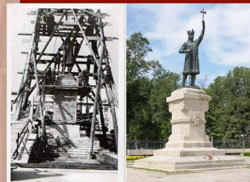
Instalarea monumentului Ștefan cel Mare și Sfânt. Monumentul Domnitorului în actualitate.
