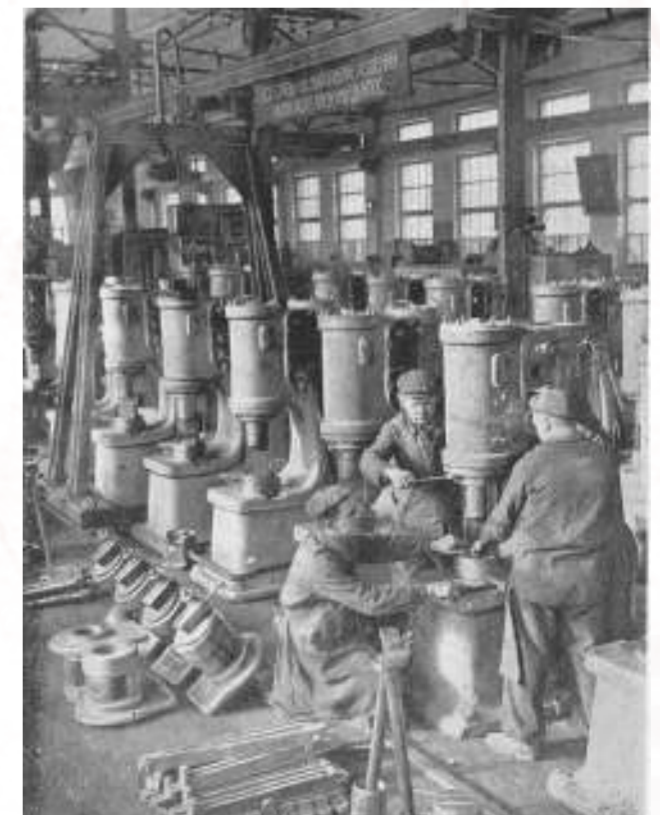
Книжник. Завод имени Г. И. Котловского. Сборка паровых насосов.
